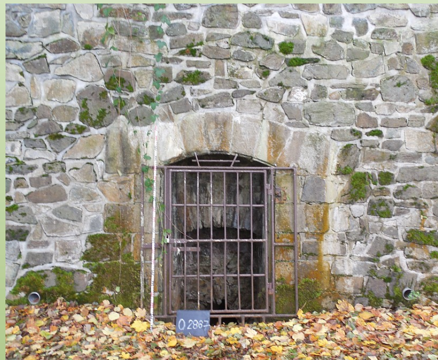
Portál dědičné štoly pod Panenskou Hůrkou
